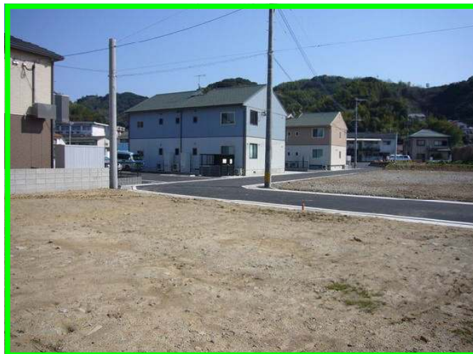
整備された宅地
