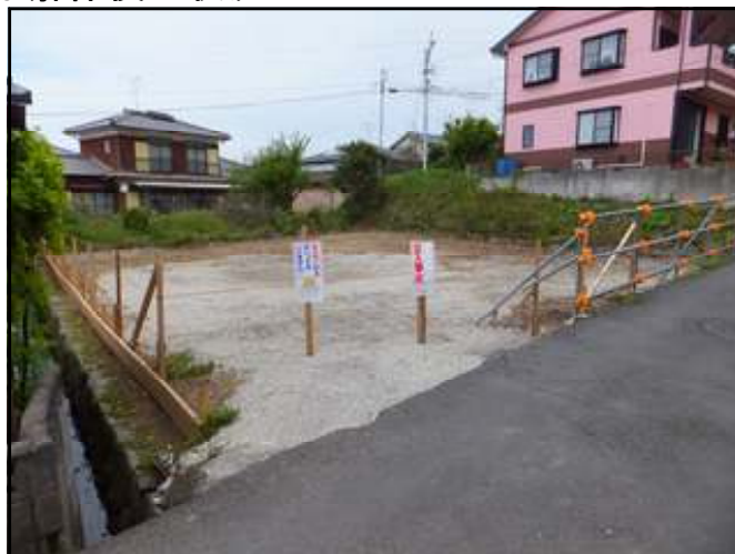
○解体後の状況
