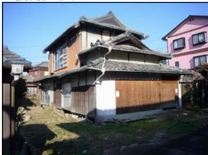
○解体前の状況
