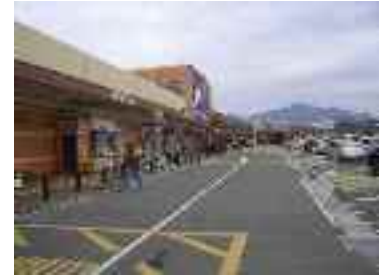
国道 206 号沿いの大型商業施設
