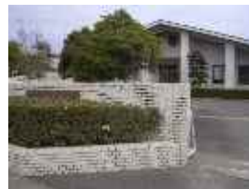
時津浄化センター
