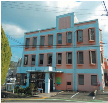
築50年経った図書館
