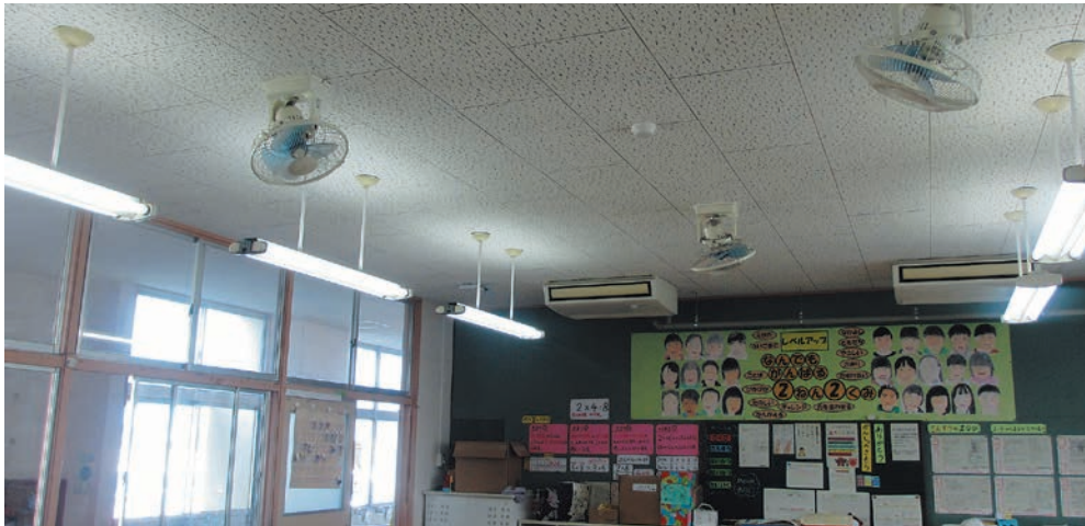
町立小中学校照明設備改修事業 (LED化) 1億5千57万4千円
