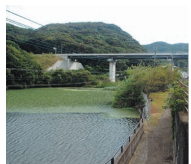
左底池の浚渫を
