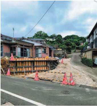
拡幅工事時の町道福島線
