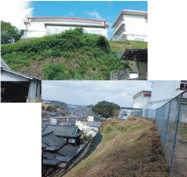
左底坂口地区急傾斜地
