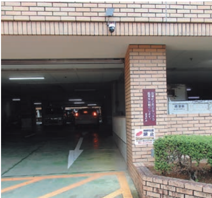
本庁舎1階駐車場出入口付近
