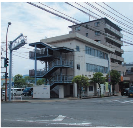
解体予定の時津公民館別館
