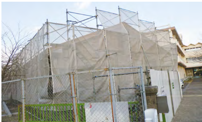
新しく建設中の「つくしんぼうクラブ」
