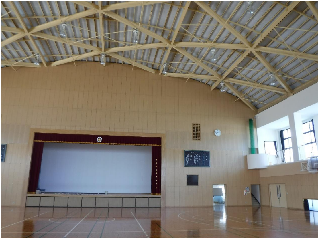
(体育館上部壁面改修工事【時津中学校】)
