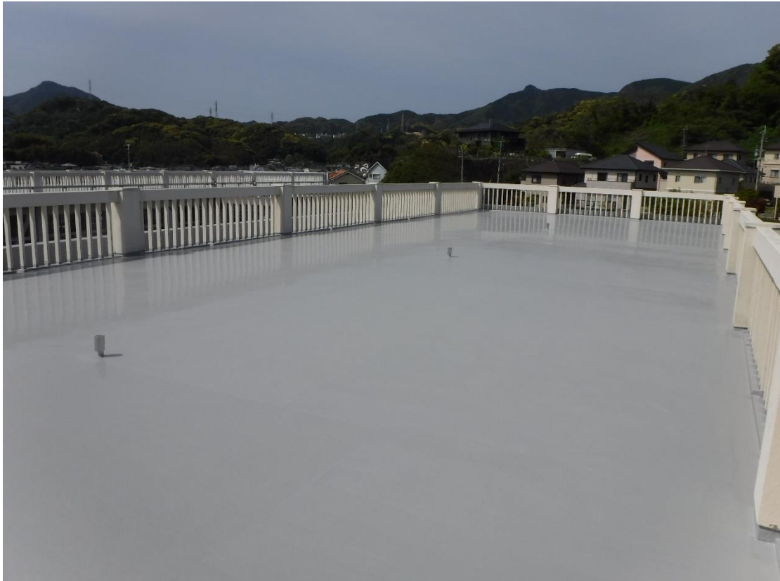
(北側校舎屋上防水改修工事【時津小学校】)
