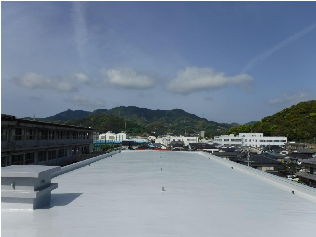
(第3棟屋上防水改修工事【時津中学校】)
