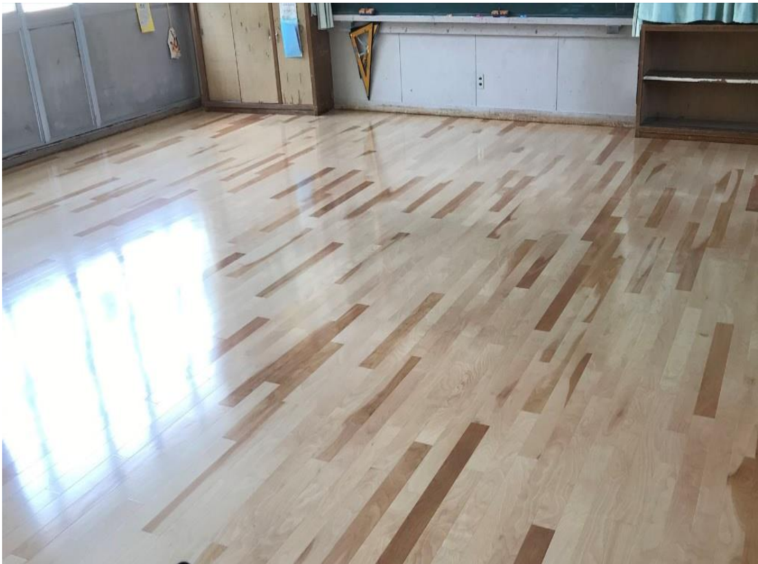
(1階東側教室床張替工事【時津東小学校】)
