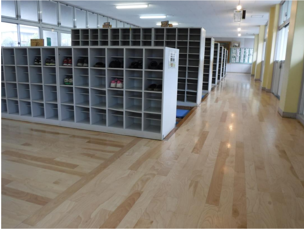
(時津東小学校 児童用玄関床張替工事)
