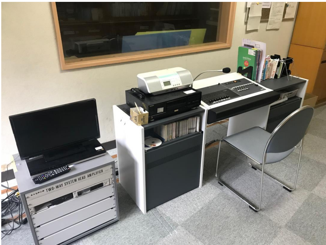
(時津東小学校・鳴鼓小学校 放送設備更新工事)
