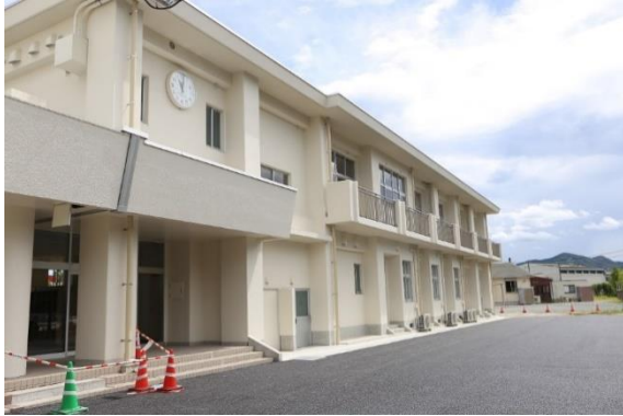
【時津北小学校：増築建物外観】
