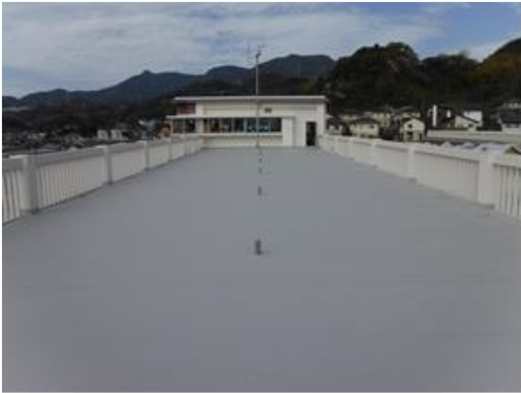
(時津小学校 屋上防水改修工事)
