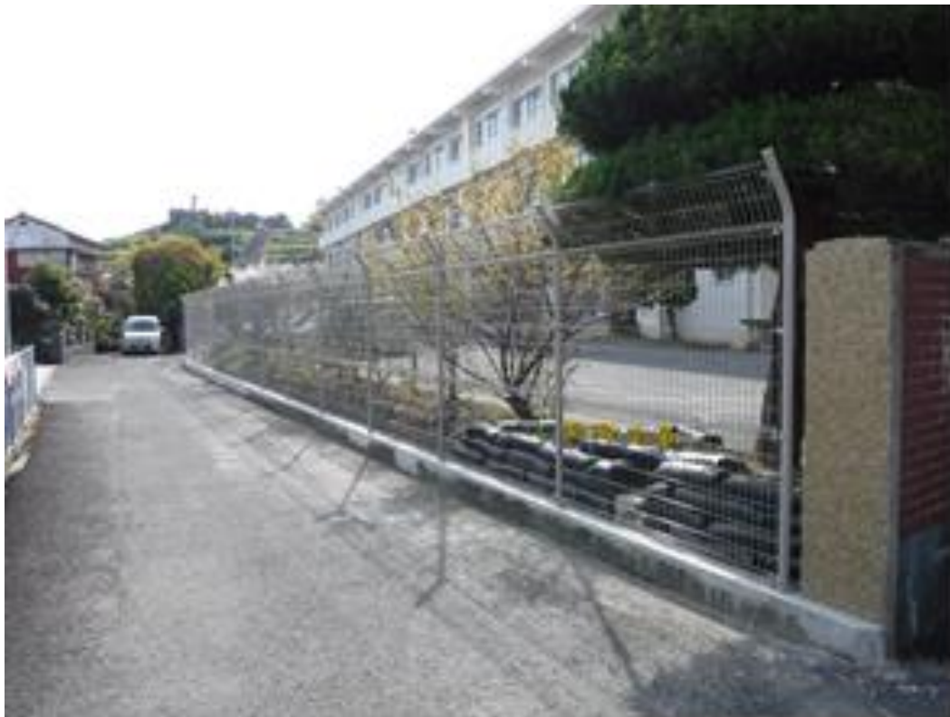
(時津東小学校 既存ブロック塀改修工事)
