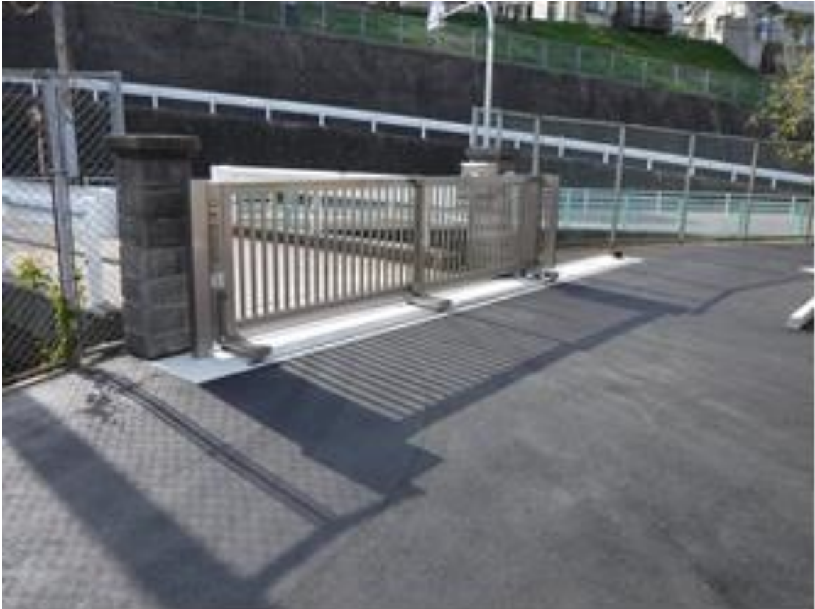
(時津小学校 門扉取替工事)
