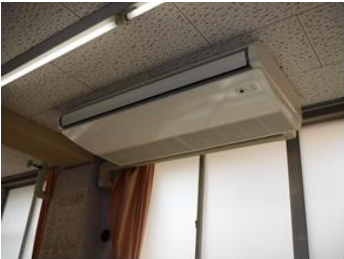
(時津東小学校 保健室空調機取替工事)
