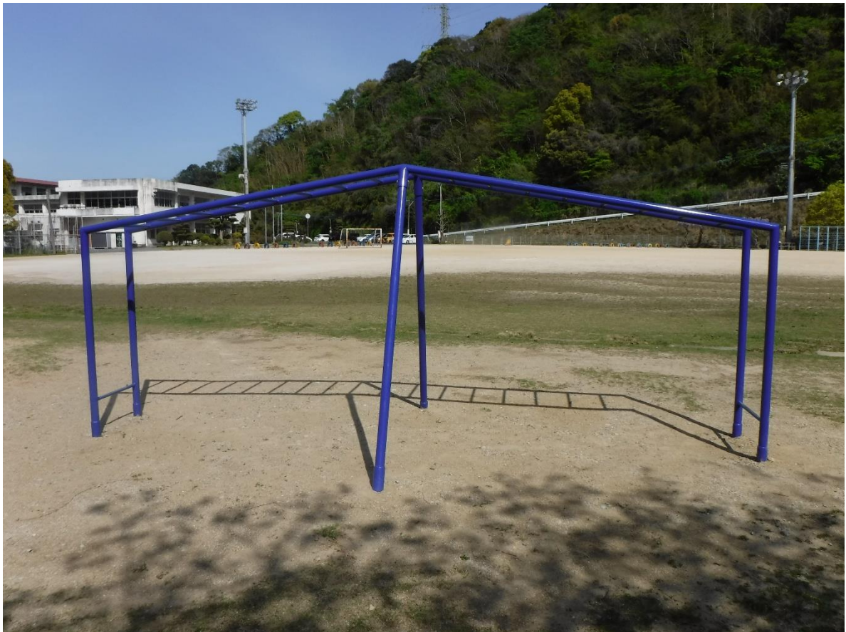
【遊具更新工事（鳴鼓小学校）】
