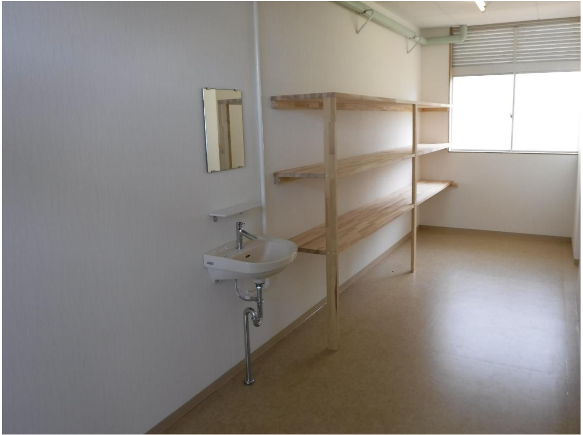
【第3棟2階トイレ内部改装工事（時津中学校）】
