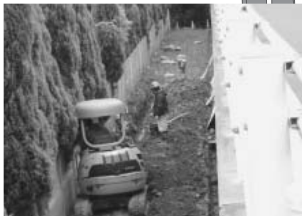
▲導水管布設工事(日並郷)
