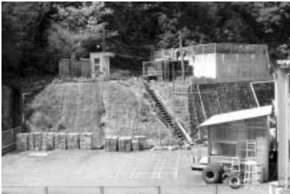
取水を予定しているクリーンセンターの井戸(左奥)
