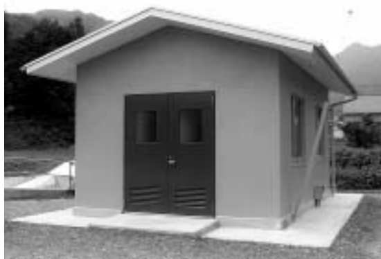
▲中継ポンプ場
