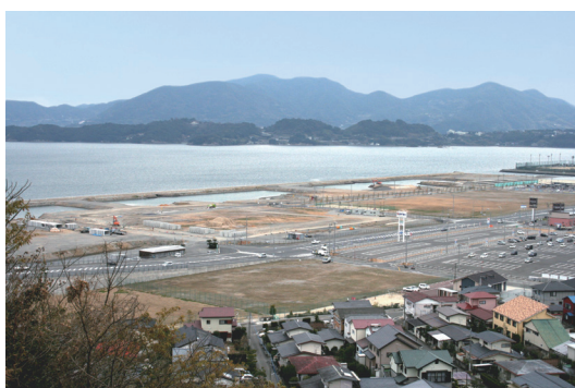
日並郷・時津第10工区付近（平成23年撮影）
